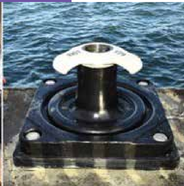
▲ Figuur 2: Voorbeeld links: WAAM 3D-geprinte bolder. Rechts: smart bolder in de regio Rotterdam.
